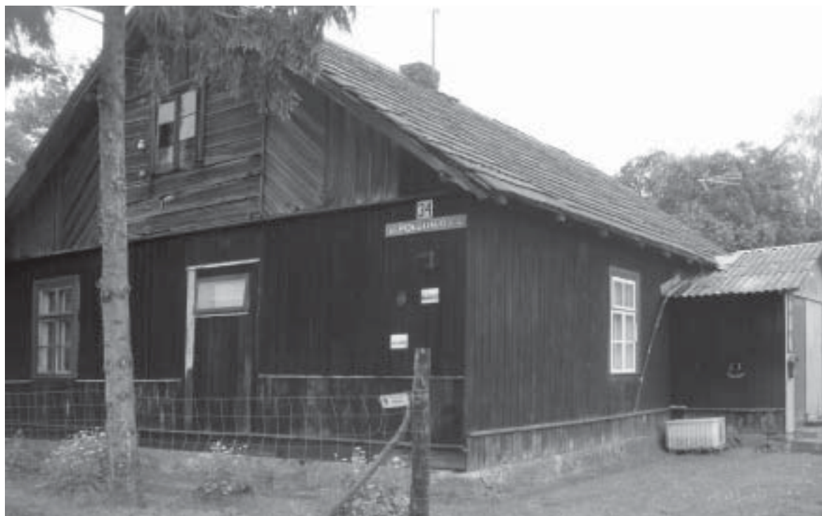
Dom przy ul. Południowej w Łapach
