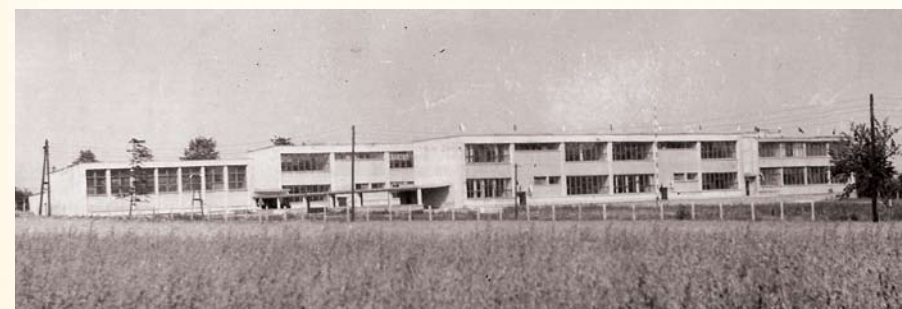
7. Obiekt po zakończeniu budowy
