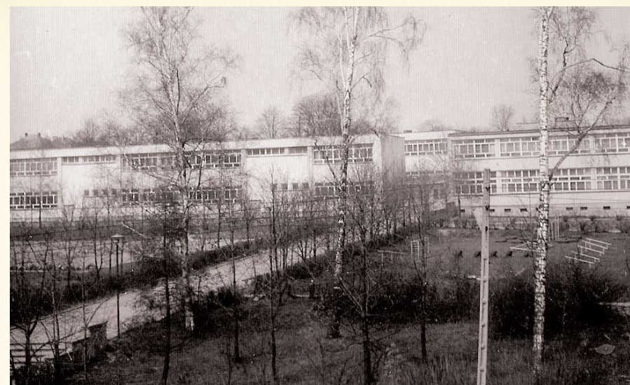
9. Widok na budynek; lata 70. XX wieku
