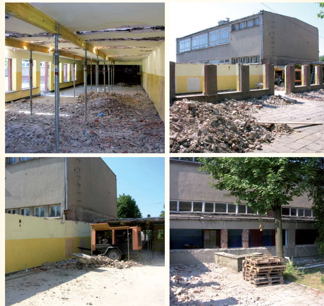
12./13./14./15. Budynek w czasie remontu – lipiec 2006 r.
