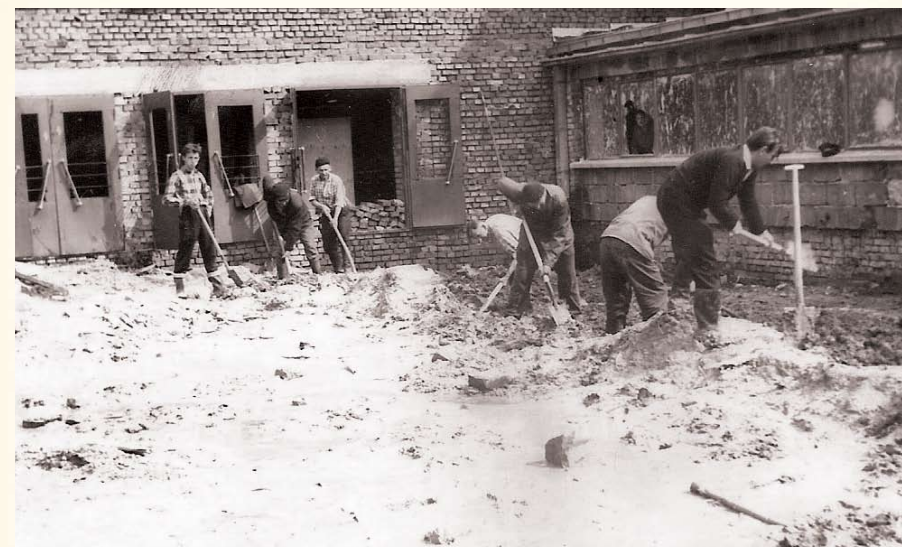
6. Budowa szkoły – czyn społeczny; wartość włożonej w budowę szkoły pracy społecznej – 270 tys. zł
