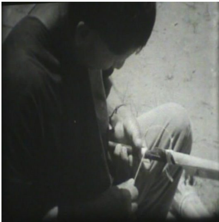
Fot. 44. Cofán. Owijanie sznurkiem miejsca połączenia grotu z drzewcem. Fot. B. Malkin. Kadr z filmu Making a Spear . Santa Rosa de Sucumbios 1970 r.
